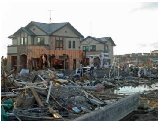
図1-5 東日本大震災 被害の様子
