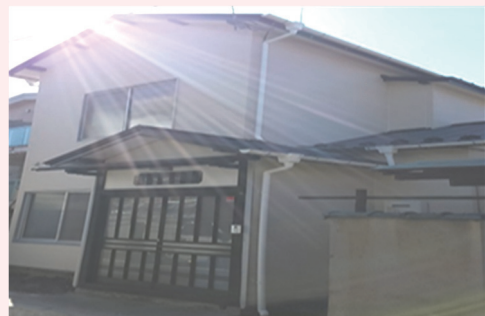
▲空き家を活用した支援住宅も建築
