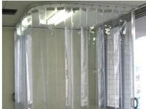
塩ビシート (カーテンレール設置)
