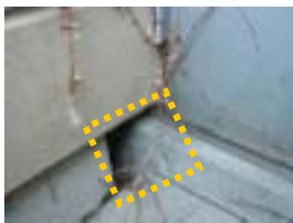
建物の基礎のすき間
